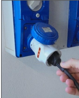
Abbildung 5 – Stecken Sie den Netzstecker.
